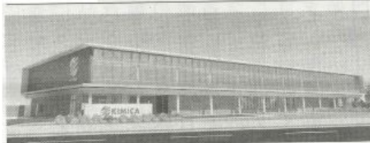
24×70メートルの柱の無い大空間を創出
