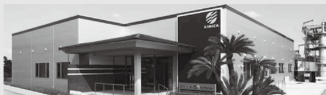
千葉プラント管理棟
