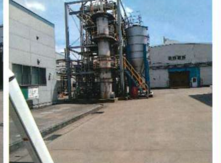
アルギン酸生産工場全景、レソニア粉末とアルカリ処理タンク群 屋内で、脱水、乾燥、粉末までの過程が行われているが従事者が少ない。 (千葉県君津市)
