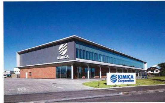
千葉プラント施設（事務・研究分析・開発・試作実験など（同社HPより）
