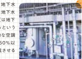
輻射空調の熱源に、地下水を活用しました。冬は地下水から熱を取り出し、夏は地下水に熱を吸収させるというアイデアで、一般的な空調システムと比べると50%以上も環境負荷を低減させることに成功しました。
